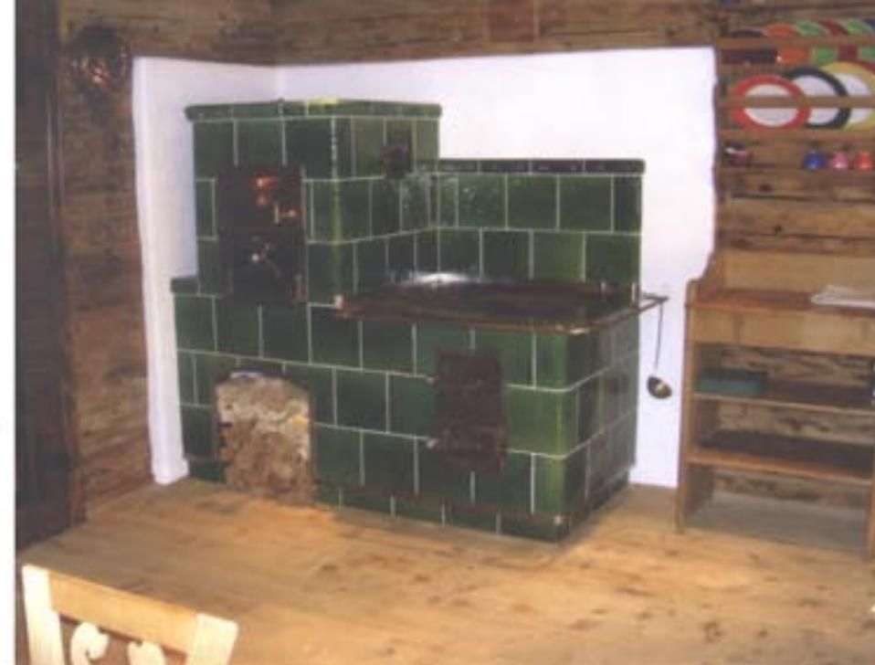
Aus einem alten Herd, dessen beschädigte und fehlende Kacheln restauriert bzw. reproduziert und Metallteile neu angepasst werden mussten, entstand ein neuer Durchheizherd
