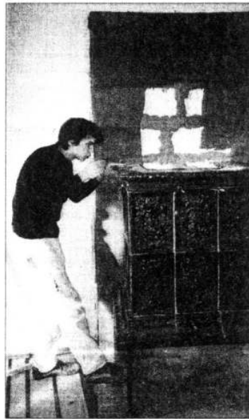
Um den Ofen wieder in den Originalzustand zu bringen, waren viele Stunden Handarbeit notwendig. Unter anderem mussten viele Kacheln nachglasiert oder zusammengeklebt und einige Motivkacheln reproduziert werden. Fotos: Haas
