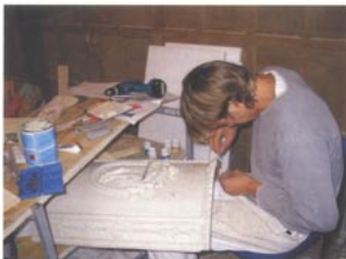
David Haas bei den Restaurierungsarbeiten
